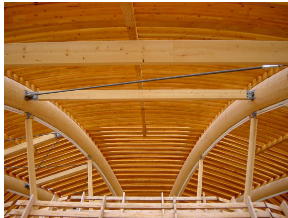
Détail de la structure.
