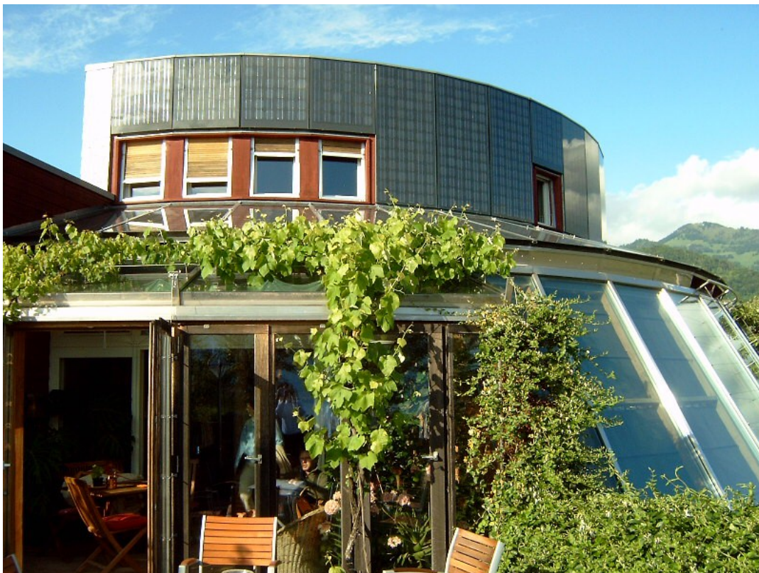
L'exemple d'une maison ECO-BIO bien connue : la maison Clée-de-Sol à Vevey
